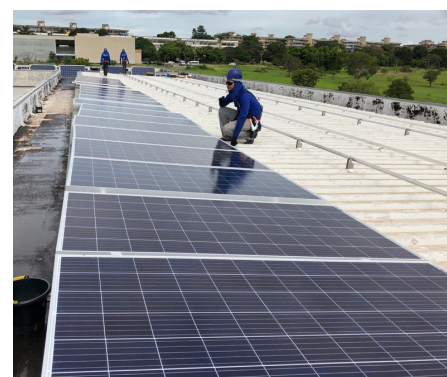
Usinas Fotovoltaica - Darcy Ribeiro
