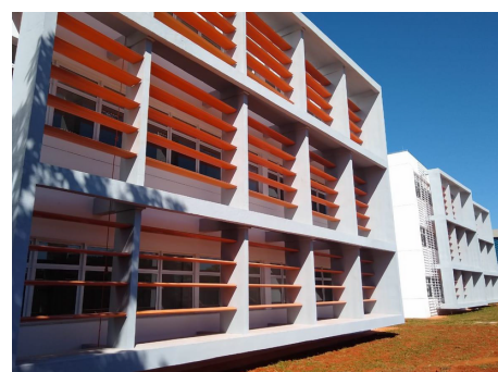
Prédio de Engenharia Florestal - FT
